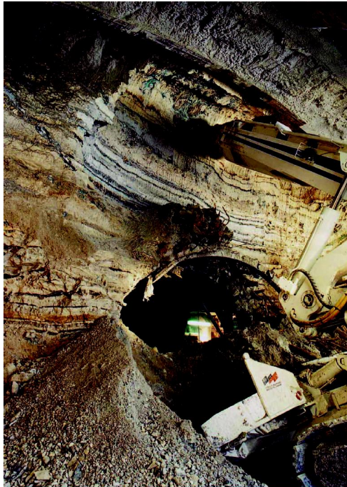
Travail de déblaiement lors du creusement de la ligne 14
